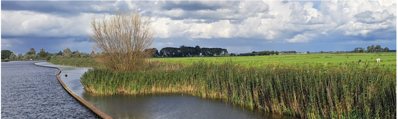
Figuur 1. De Eem ter hoogte van de Slaag met verschil in golfslag voor en achter damwand.
