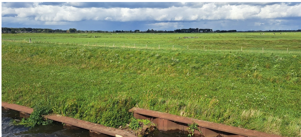
Figuur 5. Damwanden direct grenzend aan zomerkade (primaire kering) ter hoogte van de Slaag van Vereniging Natuurmonumenten.
